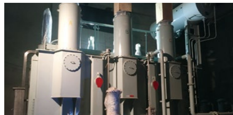
象鼻岭水电站大坝变压器安装
