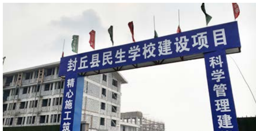
封丘县民生学校建设项目
